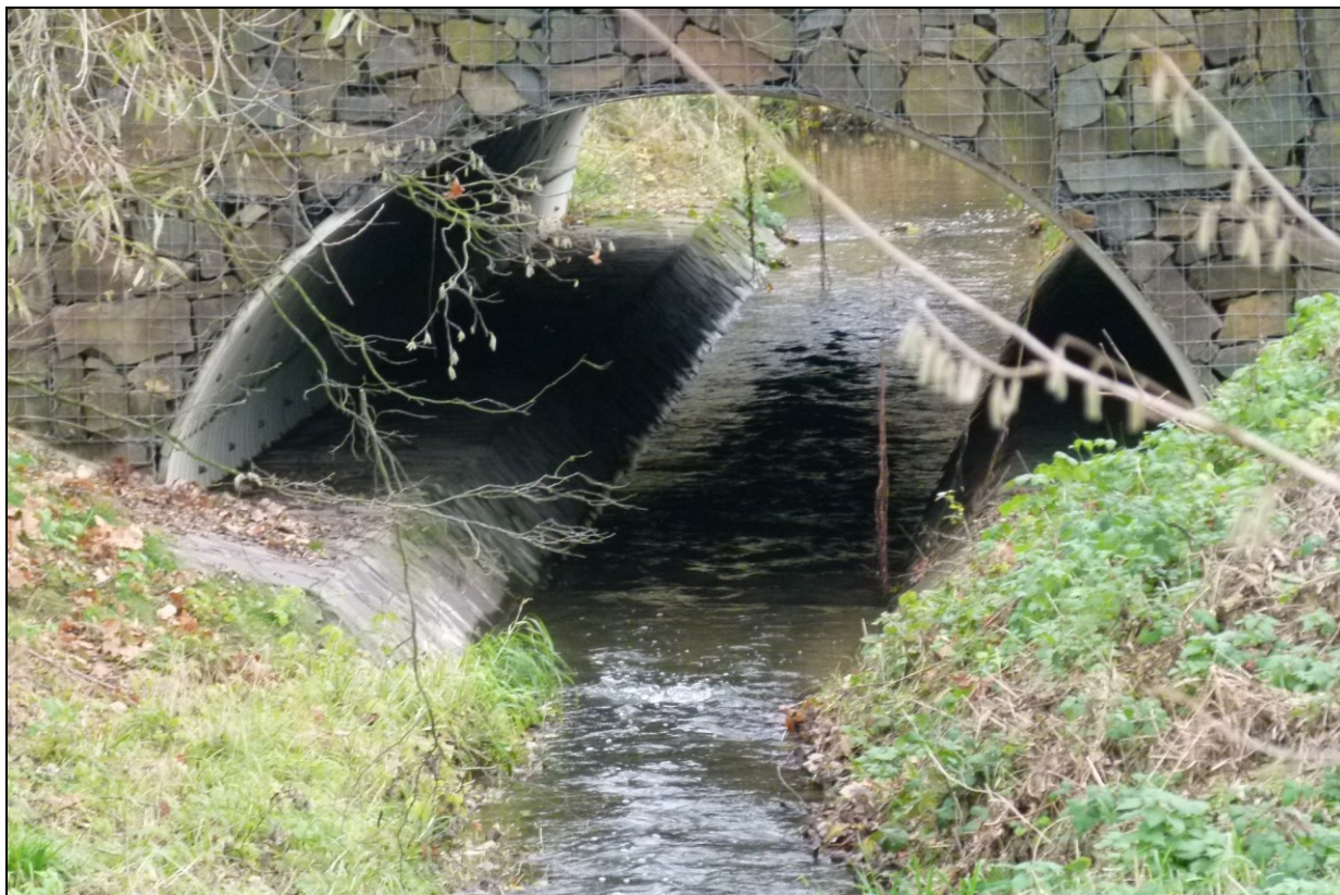
Obr. č. 3 – Nově upravované podmostí propustků a mostů na tocích musí zaručovat průchodnost pro živočichy na „sucho“. Na snímku je relativně vhodně provedené podmostí jednoho z mostků na křížení Polančice a silnice ČS. armády u Zámeckého rybníka.
